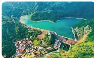
水力發電 (水壩) ( water dam )
